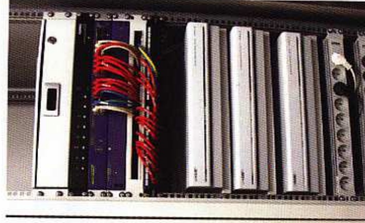
Szafy CCTV z serwerami w pomieszczeniu BMS budynku Centrum Mechatroniki Biomechaniki i Nanoinżynierii
